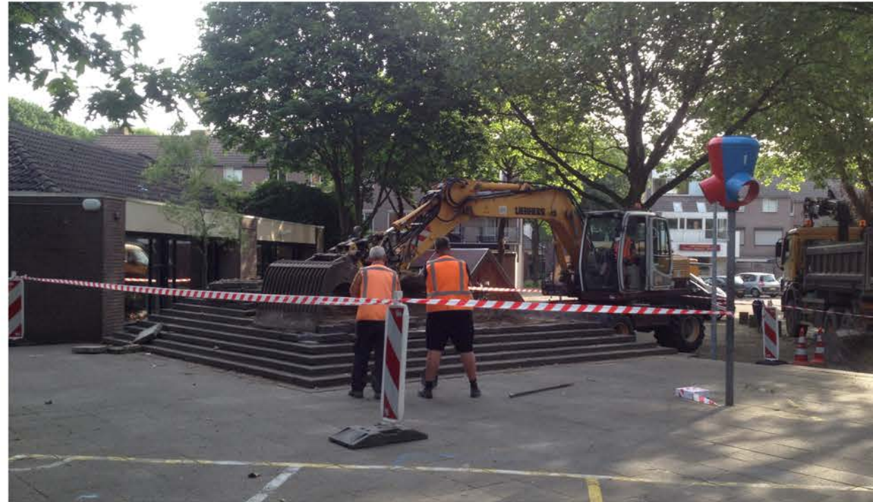
Verwijderen van de pyramide bij de onderbouw
